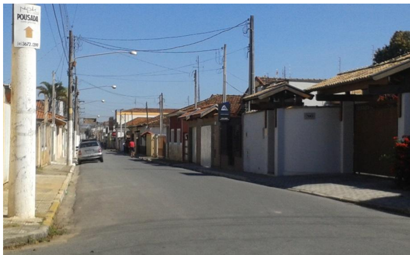
Figura 84 - Rua Costa Cabral sentido Rodovia Pedro Celete (trecho de mão única). Nota-se que a via é mais estreita e que não há qualquer tipo de regularização de velocidade ou de estacionamento ao longo da via, assim como as calçadas são estreitas e não acessíveis (IPPLAN, 2015).
