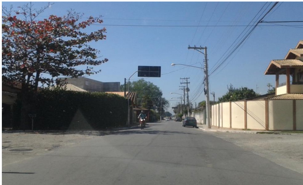
Figura 9. Rua Costa Cabral sentido Pindamonhangaba (trecho de mão dupla). Nota-se ausência de sinalização vertical e horizontal indicando preferência de circulação, nem faixas para pedestres e ciclovia (IPPLAN, 2015).
