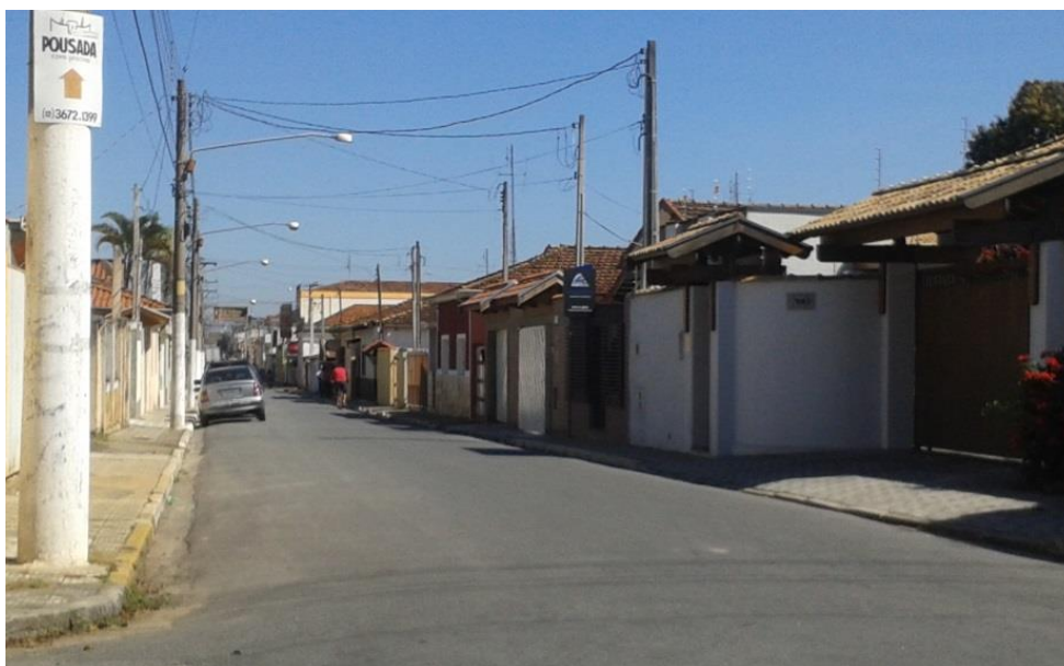
Figura 8. Rua Costa Cabral sentido Rodovia Pedro Celeste (trecho de mão única). Nota-se que a via é mais estreita e que não há qualquer tipo de regularização de velocidade ou de estacionamento ao longo da via, assim como as calçadas são estreitas e não acessíveis (IPPLAN, 2015).
